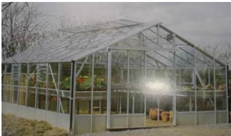
Hình 2.16: Nhà kính độc lập khung kim loại.
