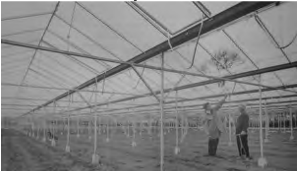
Hình 1.10: Dạng nhà kính chữ A nổi niếp.
