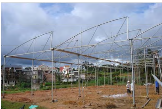
Hình 2.14: Bộ khung nhà kính đã hoàn thành.
