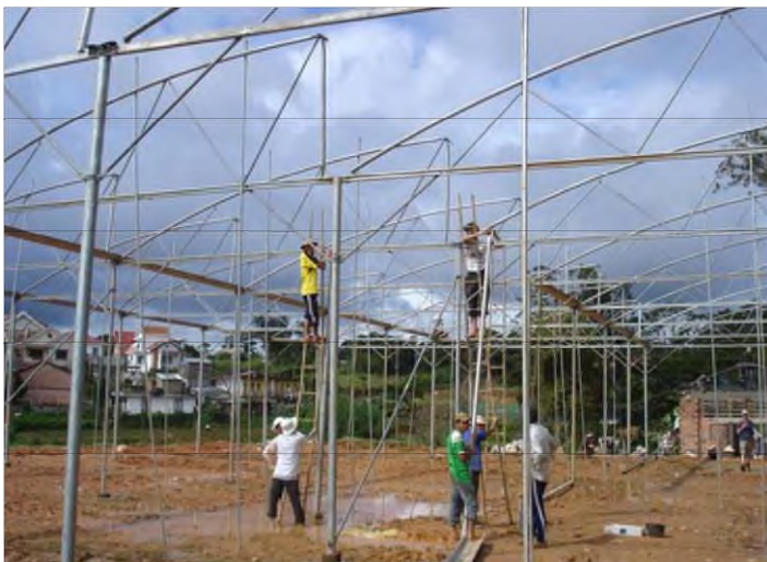
Hình 2.12: Lắp đặt bộ khung nhà kính, nhà mái che.
