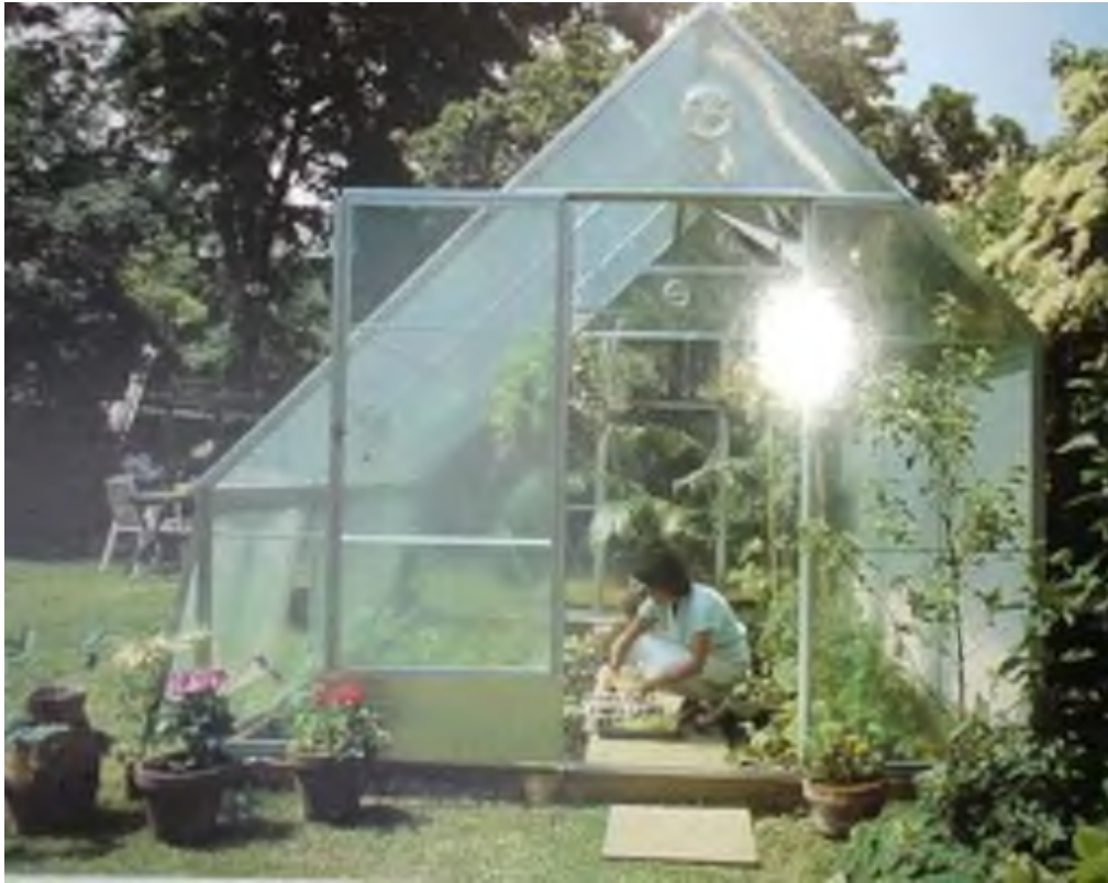
Hình 2.19: Dạng nhà plastic khung kim nhôm 2 mái không đối xứng.
