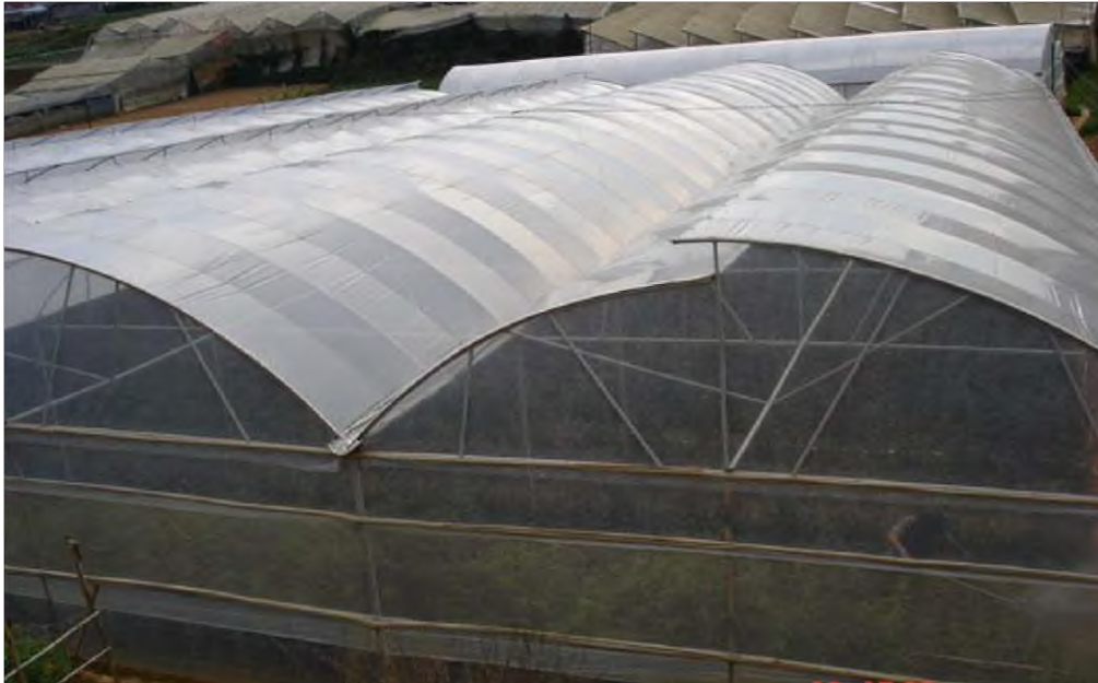
Hình 2.21: Nhà plastic dạng vòm liên tiếp.
