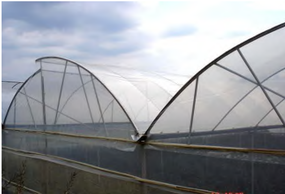
Hình 2.22: Nhà che phủ plastic dạng vòm liên tiếp.
